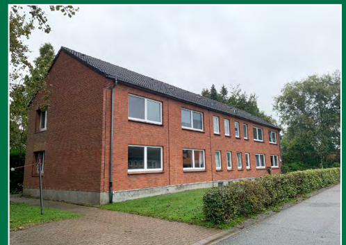
Bestandsgebäude Am Marktplatz 4-6
