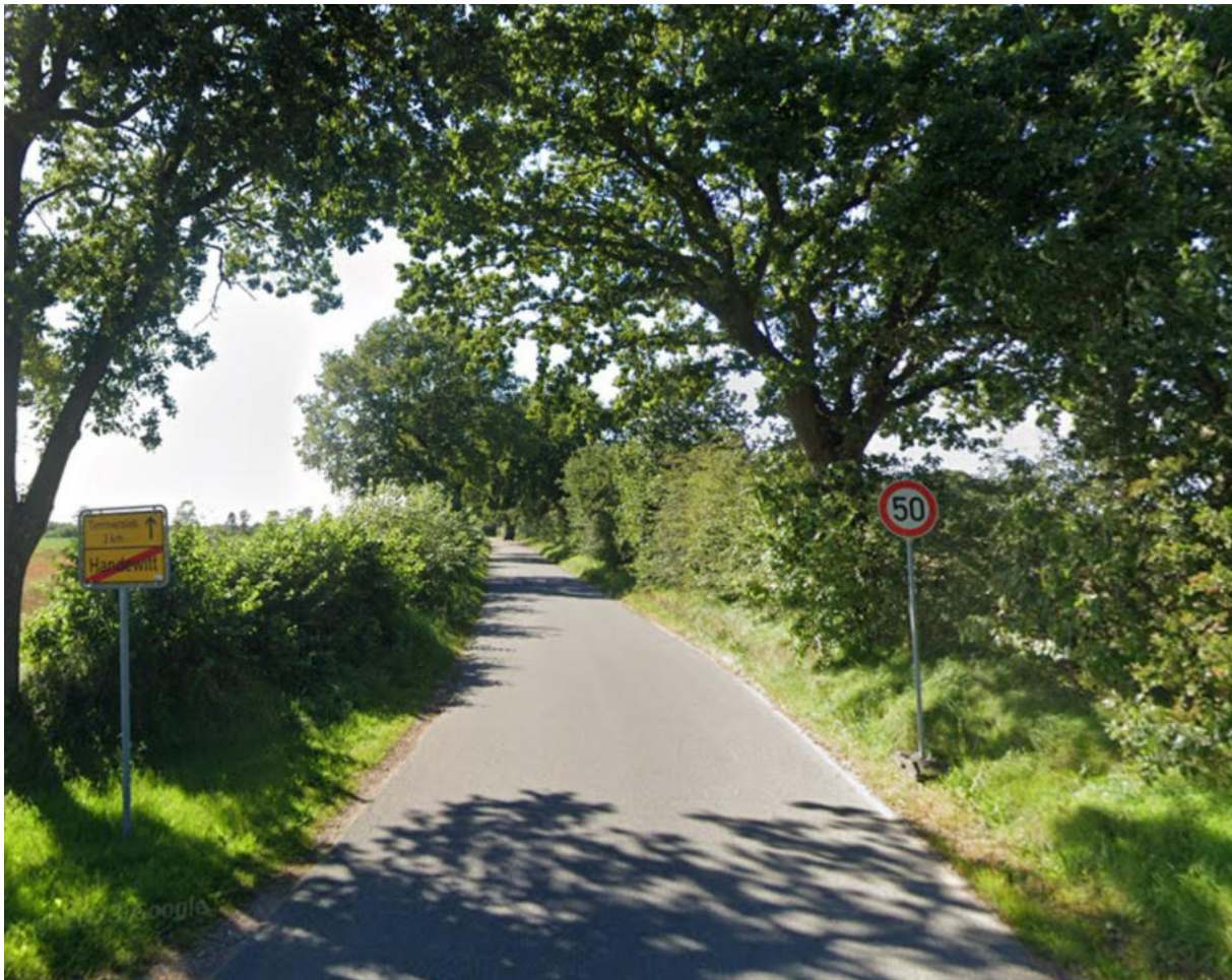
Abb. 10: Doppelknick (HWy) an der nördlichen Plangebietsgrenze (Mühlenweg)
