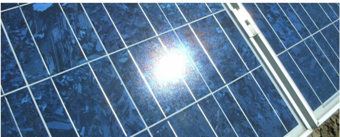
Bild 3.2.2: Diffuse Reflexion von direktem Sonnenlicht (Einstrahlung ca. 980 W/m 2 ) auf einem PV Modul (Quelle: SolPEG)
