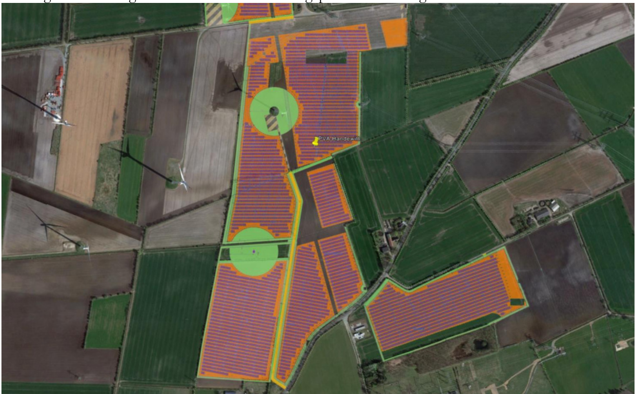
Bild 2.1.3: Detail des südlichen Bereiches der PV Anlage (Quelle: Google Earth/SolPEG)
